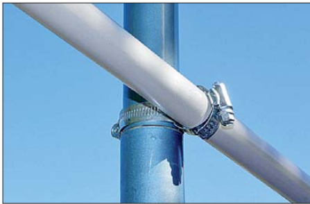
Bild 6: Kreuzverbindung des oberen PVC-Querrohrs und des Masts mit zwei Schlauchklemmen
