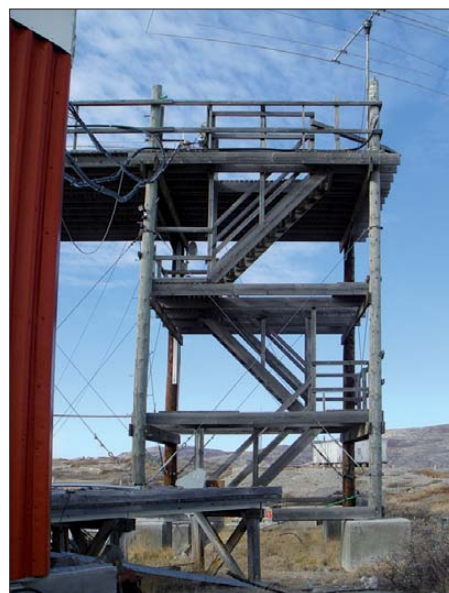
Antennenmast bei OX2A, Marke Eigenbau, mit HF-Beam und Dipolen, etwa 18 m hoch
